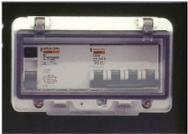
**Diese Schaltanlage enthält den Betriebsstundenzähler und den Fehlerschutzschalter**
