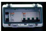
**Diese Schaltanlage enthält den Betriebsstundenzähler, den Fehlerschutzschalter, die Steckdosen und den Thermoschutzschalter**
